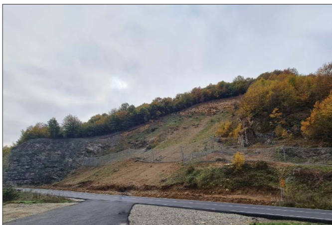
Foto 7: Fotografie de ansamblu a lucrărilor implementate
