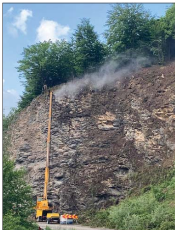
Foto 2: Realizarea ancorajelor la înălțime premergător instalării sistemului activ Tecco® G65/3
