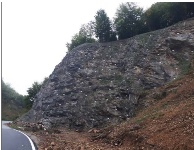
Foto 3: Versantul stânga stabilizat și protejat activ cu sistemul activ Tecco® G65/3 tip plasă ancorată de înaltă performanță
