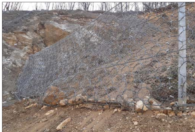
Foto 5: Bloc de rocă de 0,5 m 3 reținut în spatele barierei RXE-1000
