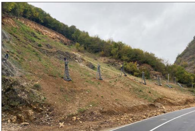
Foto 4: Instalarea montanșilor barierei RXE-1000, montanși cu plasa preasamblată
