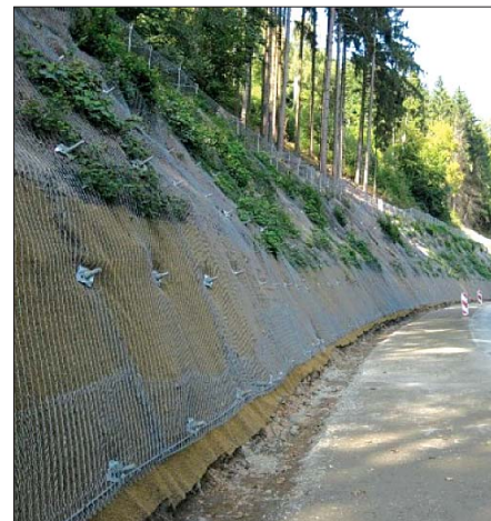
Foto 2: Stabilizare de versant cu plasă din oțel de înaltă rezistență și rețea antierozională
