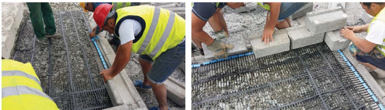
Instalare simplă, manuală, fără macarale sau sprijiniri
