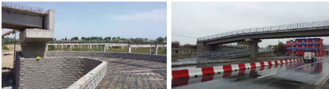
Pasaj Năvodari - executat cu Sistemul TENSAR® TW1 (2016)
